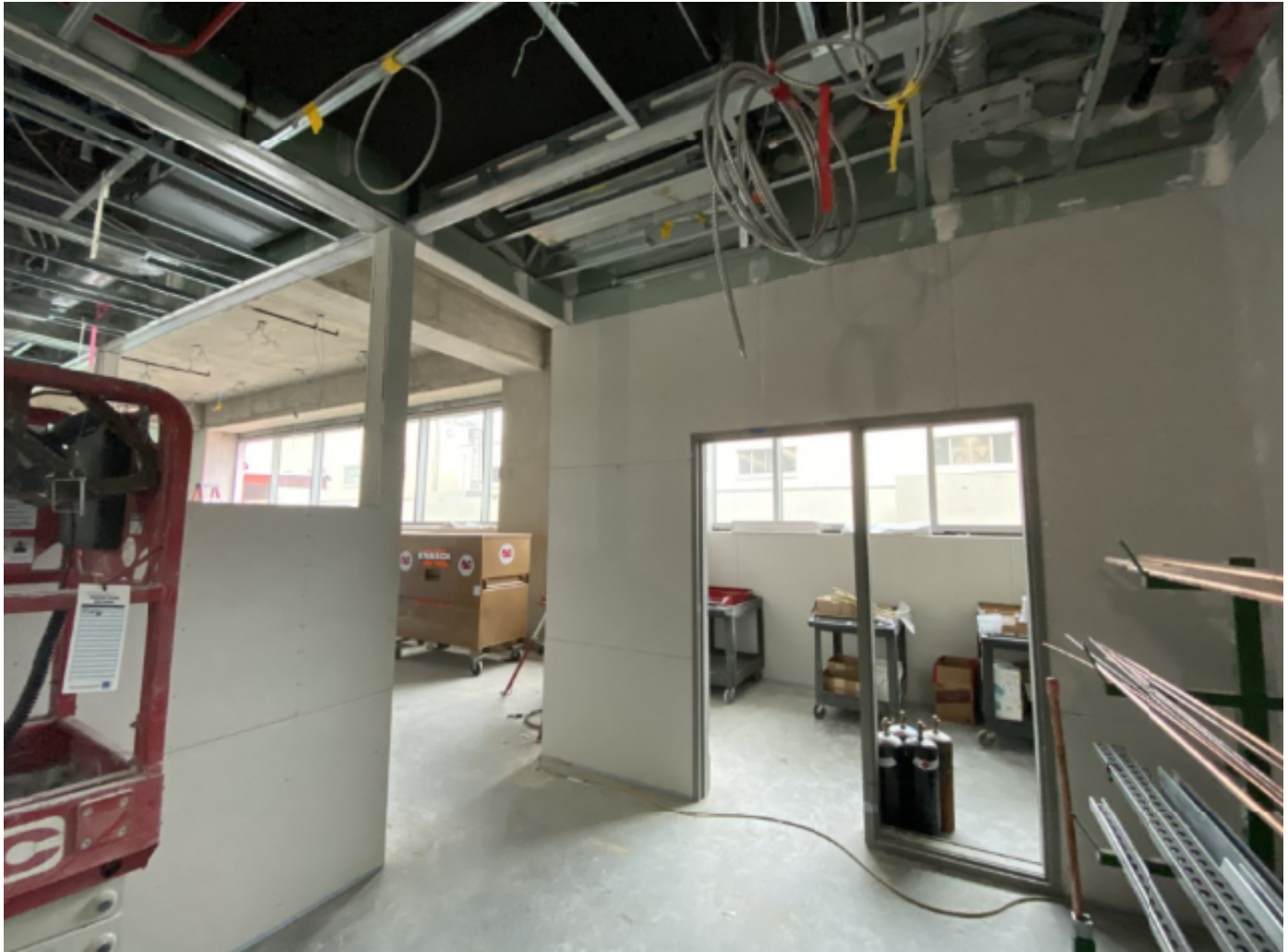
Drywall for L1.
